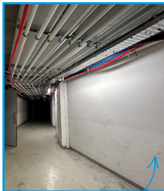
Couloir du sous-sol
