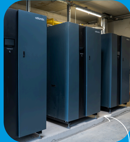
Le chauffage des halls est assuré par des chaudières Varmax 2 de 500 kW, en relais de la pompe à chaleur en situation de défaillance
