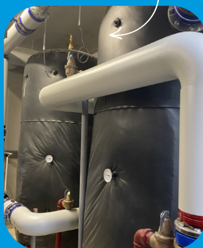
Le chauffage des halls est assuré par des chaudières Varmax 2 de 500 kW, en relais de la pompe à chaleur en situation de défaillance
