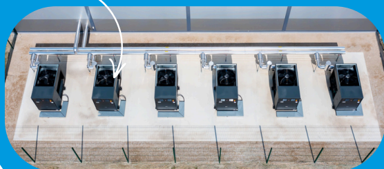
Les PAC Aptae fournissent la chaleur à un réseau équipé d'un traçage électrique de protection contre le gel
