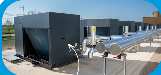
Les PAC Aptae fournissent la chaleur à un réseau équipé d'un traçage électrique de protection contre le gel
